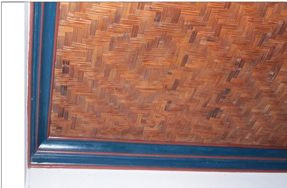
Figura 139. Forro de esteira de taquara da sala 4 desnivelado devido umidade e com presença de manchas brancas (fungos) - Fazenda Boa Esperança. Foto: Isabella Alves, 19/01/2022.
