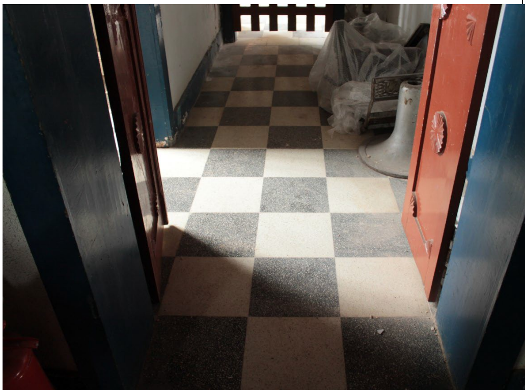
Figura 132. Piso de marmorite da sala 5 (corredor próximo à cozinha), bem conservado. Foto: Brenda Souza, 17/02/2022
