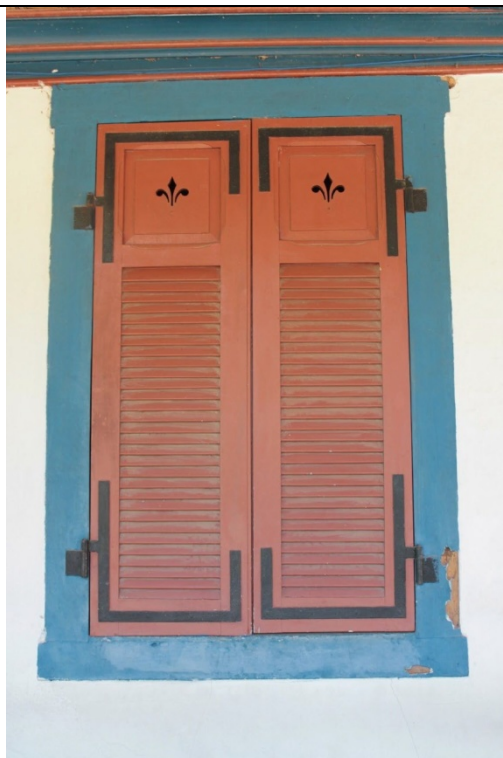
Figura 95. Janela da sala 8, vista de fora, com vestígios de presença de espécie xilófagas e parte de tinta descascadas. composta por 4 folhas de abrir, duas para fora (de madeira) e duas para dentro (de madeira e vidro) do cômodo. Foto Isabela Alves, 19/01/2022.
