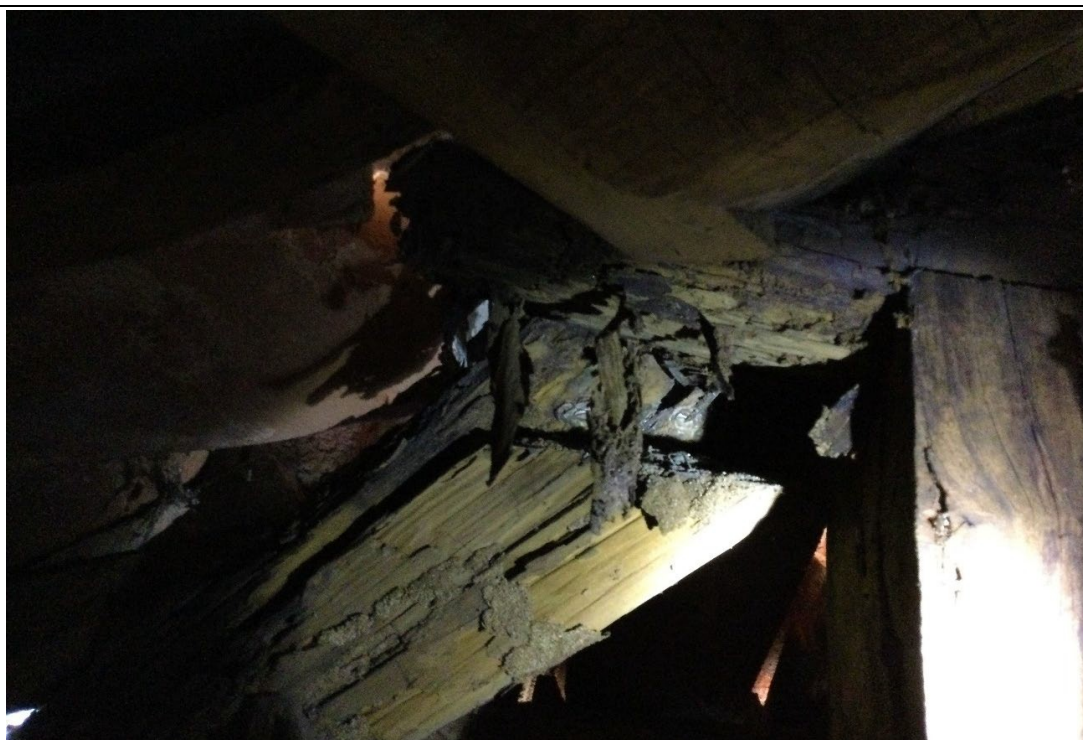
Figura 67. Vista de parte da estrutura da cobertura – Fazenda Boa Esperança. Desgaste e perda de massa. Foto: Rogério Narciso, 16/03/2022
