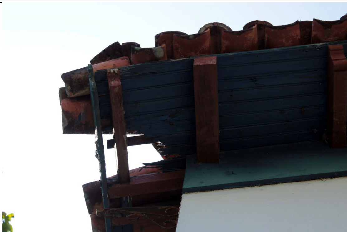
Figura 77. Beiral da lateral oeste da casa sede com perda de massa – Fazenda Boa Esperança. Esquina com fachada posterior. Visível deslocamento de telhas da cobertura. Foto: Brenda Souza, 16/03/2022.
