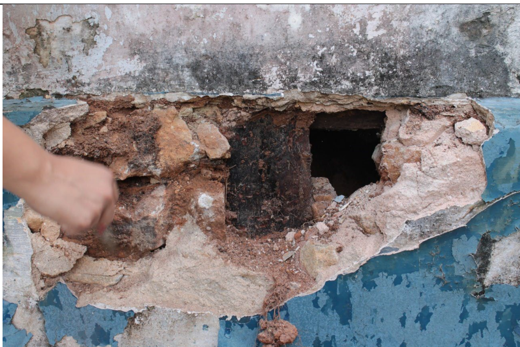
Figura 83. Janela de prospecção da parede de vedação do baldrame localizada no lado esquerdo (oeste) da fachada frontal. Ao centro da foto, esteio de madeira entre duas tipologias construtiva. Parede de pedregulho. Foto: Brenda Souza, 17/02/2022.
