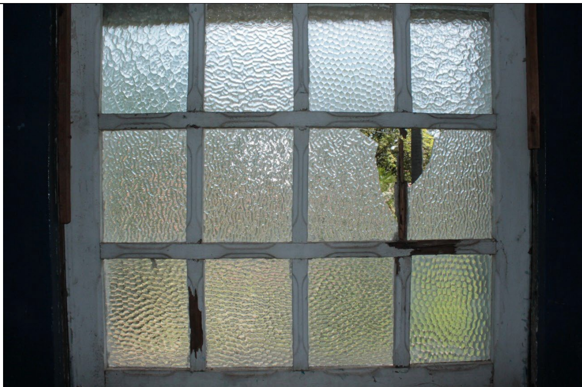
Figura 98. Janela da sala 6 (banheiro próximo à cozinha) do tipo guilhotina, vista de dentro, com presença de diferentes modelos de vidro. Foto: Brenda Souza, 23/02/2022.
