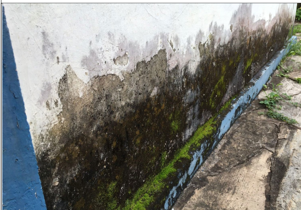
Figura 85. Vista do lado direito (leste) da fachada frontal, área do tanque/lado externo da cozinha – Fazenda Boa Esperança. Parede com muitas manchas escuras em sua base e algumas pichações. Foto: Brenda Souza, 17/02/2022.
