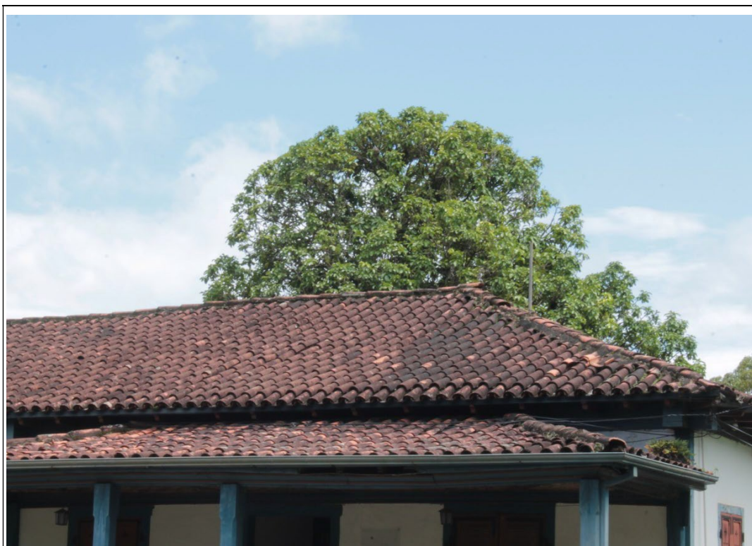
Figura 70. Vista da calha do alpendre frontal da casa sede – Fazenda Boa Esperança. Única parte do telhado com calha. Cobertura composta por telha cerâmica colonial. Foto: Brenda Souza, 17/02/2022
