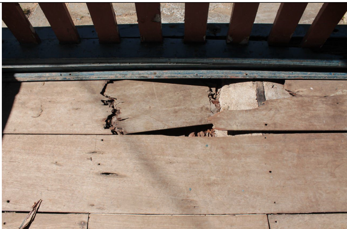
Figura 121. Piso de madeira tabuada da varanda em frente a edificação com parte quebrada - Fazenda Boa Esperança. Foto: Isabella Alves, 19/01/2022.
