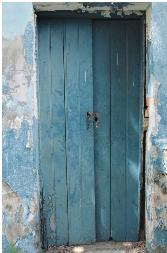
Figura 117. Porta do depósito/porão, vista de fora, composta por 2 folhas de madeira que abrem para dentro do cômodo. Tipologia de porta encontrada apenas nesse cômodo. Presença de corrente metálica para fechamento da porta que não possui fechadura ou maçaneta próp
