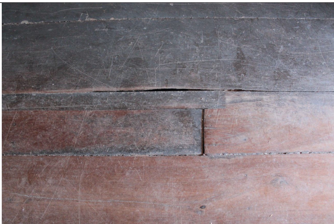
Figura 123. Piso de madeira tabuada da sala 2 (corredor da entrada), com presença de remate - Fazenda Boa Esperança. Foto: Isabella Alves, 19/01/2022.
