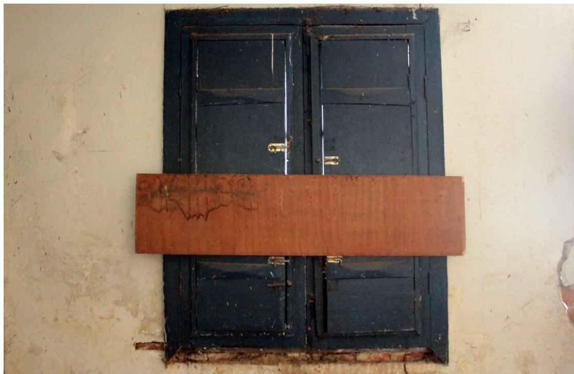
Figura 102. Janela do depósito/porão, vista de dentro, composta por 2 folhas de madeira e vidro que abrem para fora e 2 folhas de madeira que abrem para dentro. Tipologia de janela encontrada apenas desse cômodo. Presença de tabua de madeira que impede a abertura
