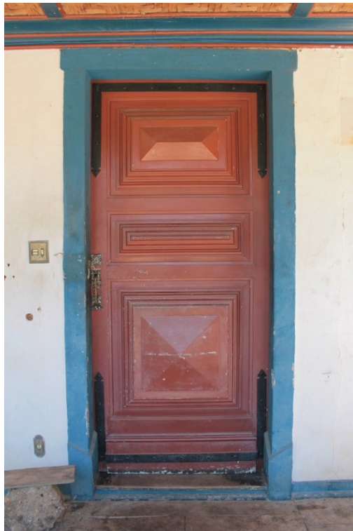
Figura 106. Porta de acesso / entrada principal da edificação, vista de fora. Composta por 1 folha de madeira maciça e detalhes ao redor feitos de material metálico pintado de preto. Tinta com partes descascada. Foto: Isabella Alves, 19/01/2022
