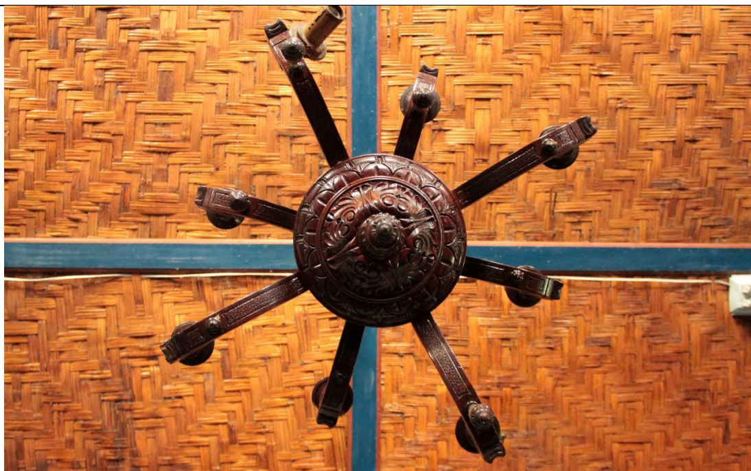
Figura 170. Luminária estilo colonial de madeira com oito boquilhas do tipo vela, localizada na sala 8, original da fazenda – Fazenda Boa Esperança. Única sala com essa tipologia de luminária presente na casa. Foto: Brenda Souza, 16/03/2022.
