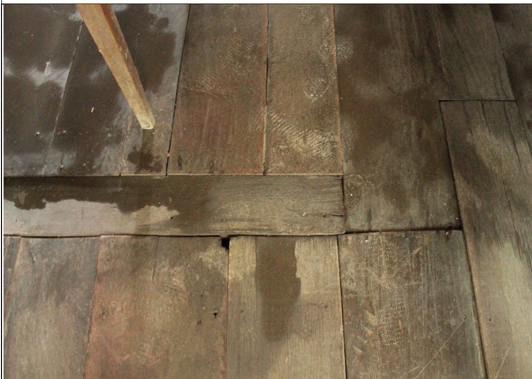
Figura 129. Piso de madeira tabuada da sala 13, com presença de remates, sobretudo próximos ao corredor perto da cozinha. Foto: Isabella Alves, 19/01/2022.
