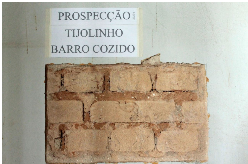
Figura 79. Prospecção da sala 5 (corredor próximo à cozinha) da casa sede – Fazenda Boa Esperança. Parede de vedação composta por tijolinho de barro cozido e argamassa de barro encontrada em parte da varanda e das salas 2, 4, 5, 7, 10, 11, 12 e 13. Foto: Brenda S
