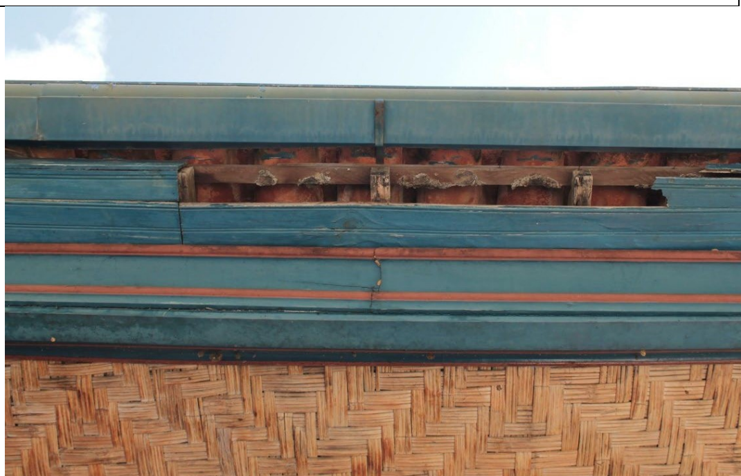
Figura 73. Vista de parte do beiral do alpendre frontal da casa sede com perda de massa – Fazenda Boa Esperança. Foto: Brenda Souza, 16/03/2022.
