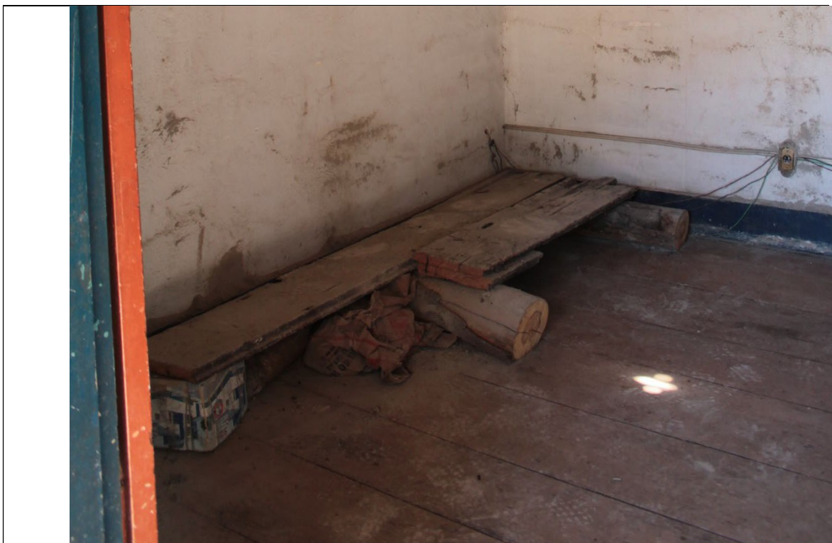
Figura 122. Piso de madeira tabuada da sala 1, com partes desgastadas, sobretudo devido a sala servir como depósito para materiais de construção - Fazenda Boa Esperança. Foto: Isabella Alves, 19/01/2022.
