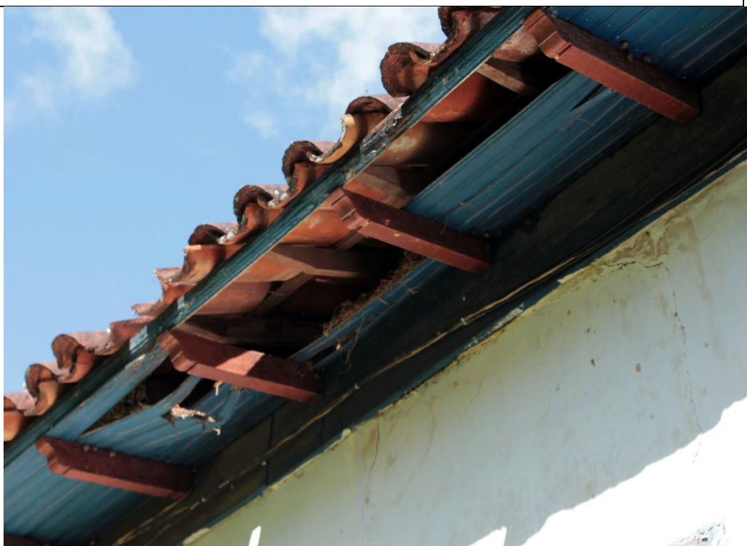
Figura 75. Vista de parte do beiral da lateral leste da casa sede com perda de massa – Fazenda Boa Esperança. Foto: Brenda Souza, 16/03/2022.
