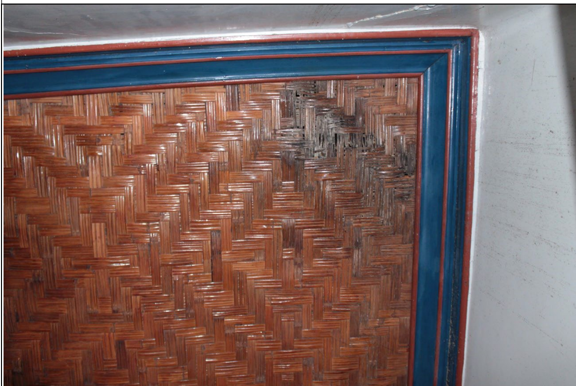
Figura 138. Forro de esteira de taquara da sala 3 (banheiro próximo à entrada) bem comprometido próximo à porta, apresentando manchas e desgaste devido a infiltração - Fazenda Boa Esperança. Foto: Isabella Alves, 19/01/2022.
