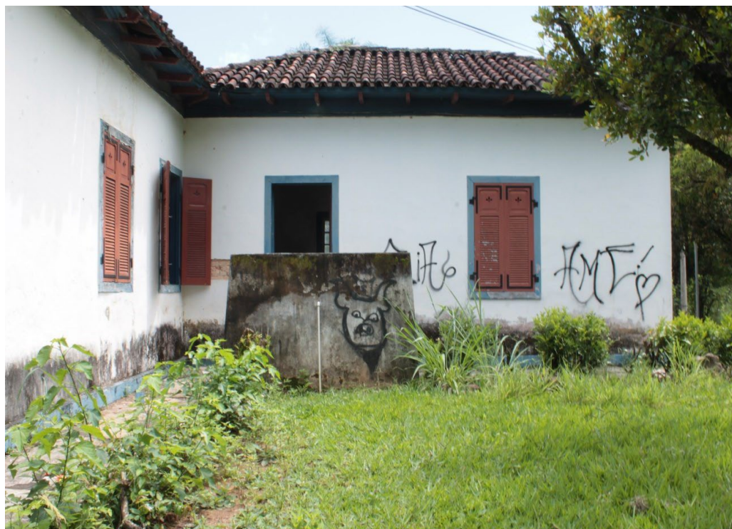
Figura 85. Vista do lado direito (leste) da fachada frontal, área do tanque/lado externo da cozinha – Fazenda Boa Esperança. Parede com muitas manchas escuras em sua base e algumas pichações. Foto: Brenda Souza, 17/02/2022.
