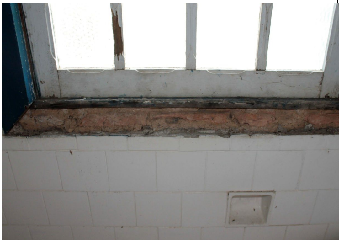
Figura 99. Janela da sala 6 (banheiro próximo à cozinha) tipo guilhotina, vista de dentro, com parte faltando na base. Tipologia de janela encontrada nas salas 6, 7, 12 e 13. Foto: Brenda Souza, 23/02/2022.
