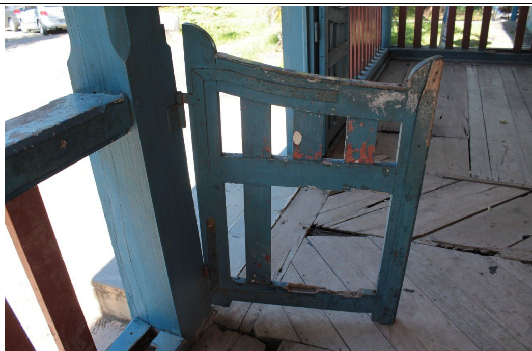
Figura 103. Portal de acesso à varanda em frente à entrada principal. Sustentada apenas por uma dobradiça, com peças de madeira faltantes e pintura desgastada. Foto: Isabella Alves, 19/01/2022.
