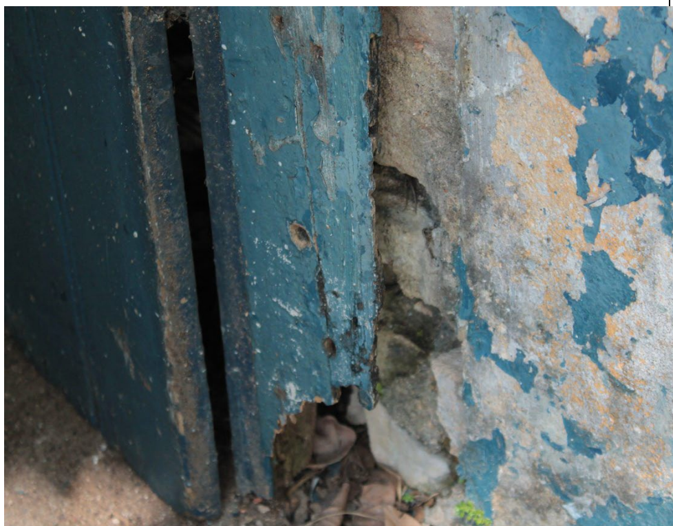
Figura 118. Parte comprometida da estrutura da porta do depósito/porão, vista de fora, composta por 2 folhas de madeira que abrem para dentro do cômodo. Foto: Brenda Souza, 16/03/2022
