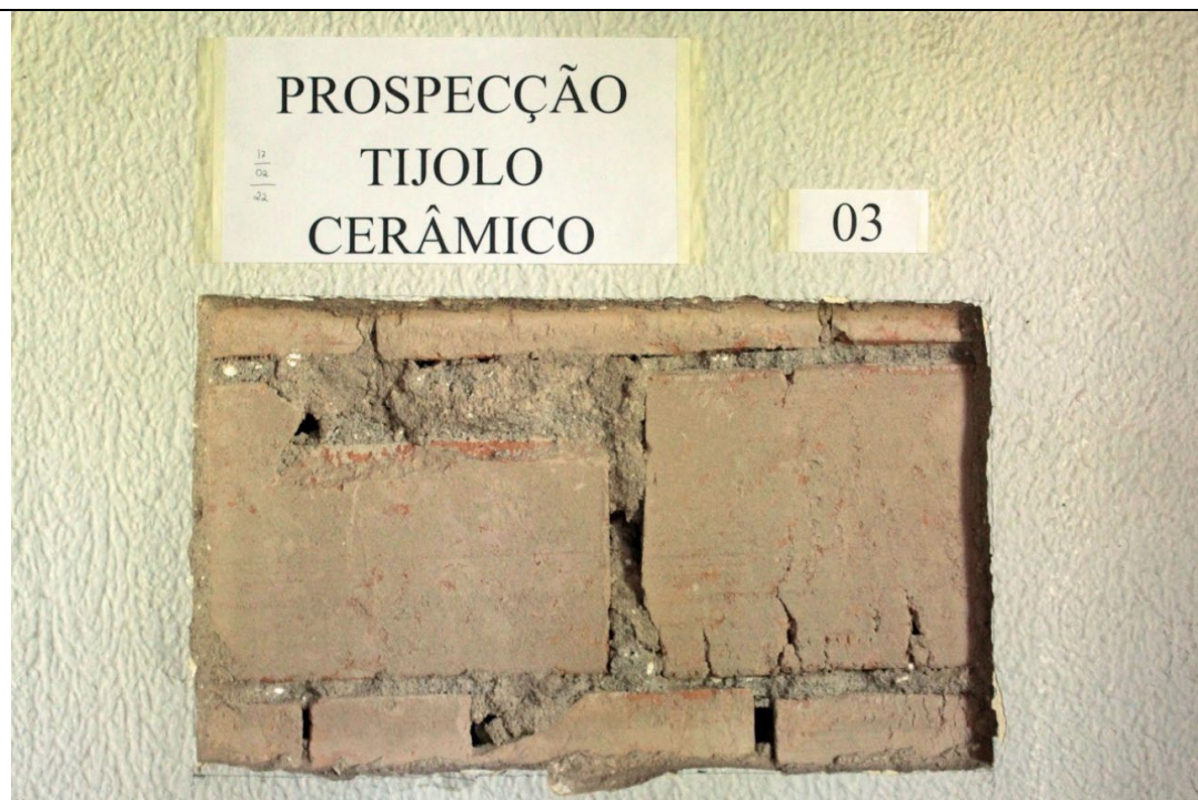
Figura 81. Prospecção nº 3 da sala 9 da casa sede – Fazenda Boa Esperança. Parede de vedação composta por tijolo cerâmico furado e argamassa de cimento e areia. Única parede desse tipo na edificação. Foto: Brenda Souza, 17/02/2022.
