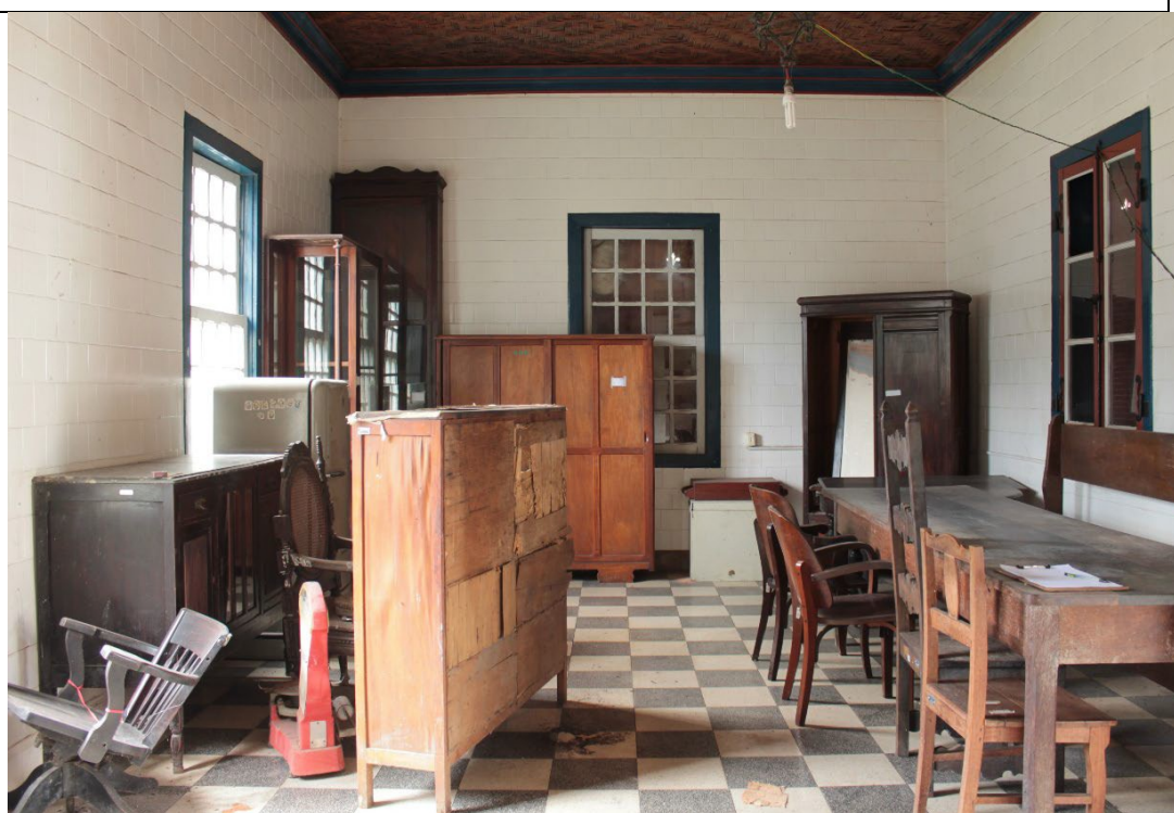
Figura 96. Sala 7 (cozinha), vista de dentro, com 3 diferentes tipologias de janela. Essas sendo, da esquerda para a direita da foto: Janela guilhotina de madeira e vidro com duas folhas; janela guilhotina de madeira e vidro com duas folhas mais duas folhas de ma
