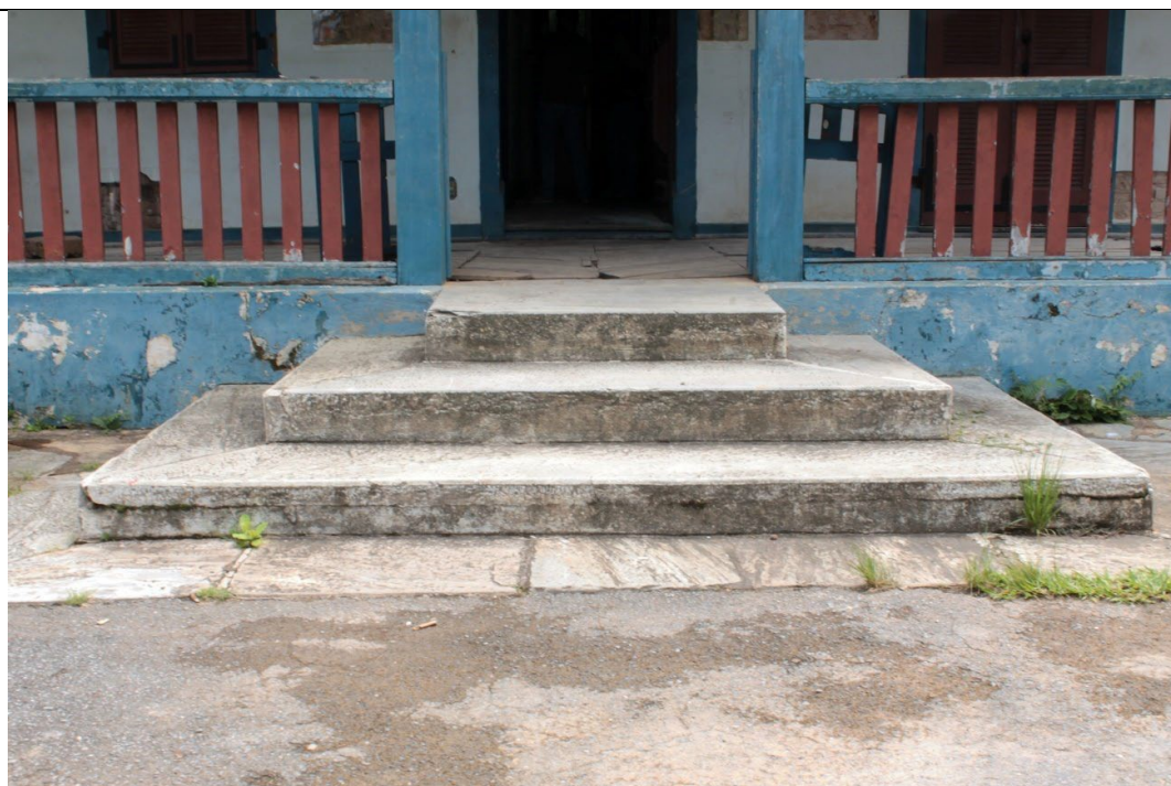
Figura 149. Escada revestida com pedra quartzito lajão que dá acesso à varanda em frente à casa sede- Fazenda Boa Esperança. Foto: Brenda Souza, 17/02/2022.
