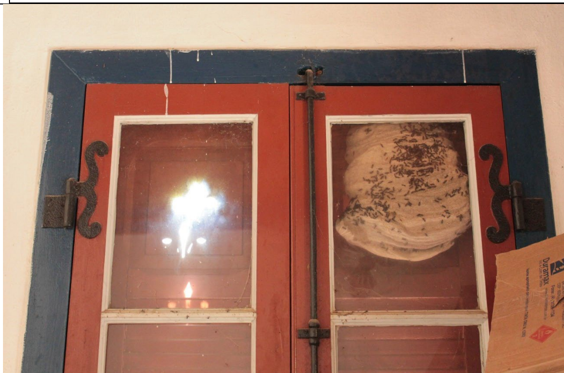
Figura 92. Janela da sala 1, composta por 4 folhas de abrir, duas para fora (de madeira) e duas para dentro (de madeira e vidro). Presença de grande colmeia de vespas/marimbondos. Foto: Isabella Alves, 19/01/2022.
