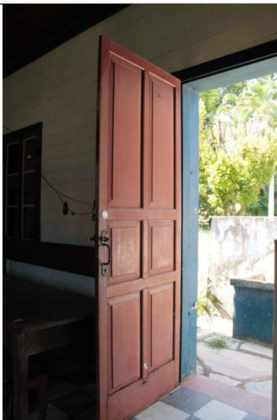
Figura 115. Portal de acesso da sala 5 (corredor) para a sala 7 (cozinha). Visto da sala 7. Composto por madeira maciça pintada de vermelho. Foto: Isabella Alves, 23/02/2022.
