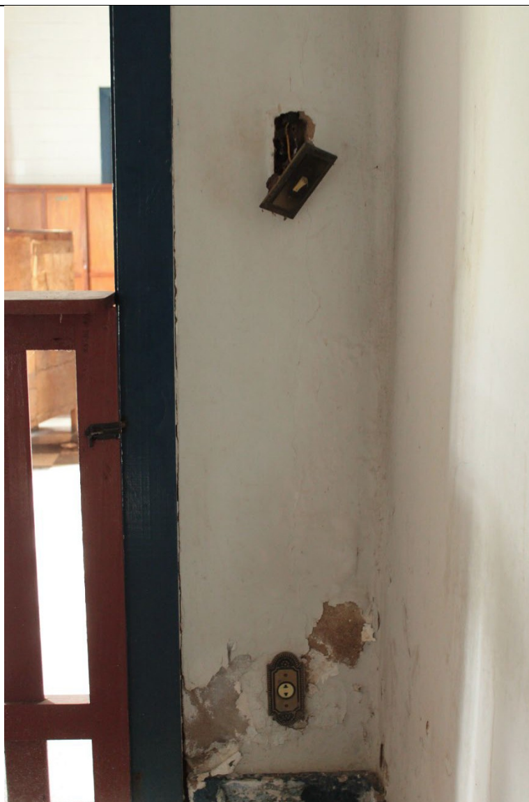
Figura 179. Ponto de tomada e interruptor em estado precário, localizados na sala 5 (corredor próximo à cozinha) – Fazenda Boa Esperança. Foto: Brenda Souza, 17/02/2022.
