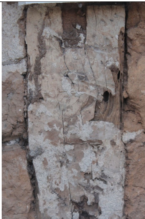
Figura 61. Prospeção nº 7 da varanda da casa sede – Fazenda Boa Esperança. Apresentação do esteio de madeira presente abaixo da janela esquerda. Esse, bem comprometido e com vestígios de presença de espécie xilófaga, além de partes com argamassa a base de cimento. Foto: Brenda Souza, 16/03/2022.
