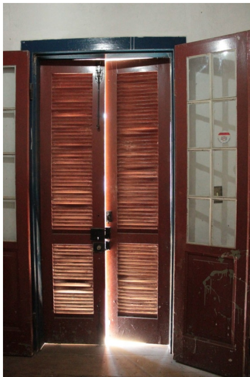
Figura 105. Porta da sala 1 vista por dentro, composta por 4 folhas de abrir, duas para fora (de madeira) e duas para dentro (de madeira e vidro). Várias partes sujas e manchadas com tinta e material de construção, supostamente devido a sala servir como depósito pa
