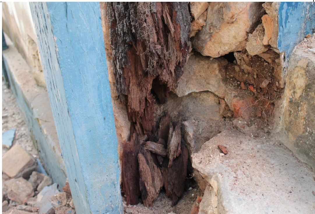
Figura 60. Prospecção feita no cunhal localizado na quina de encontro entre a lateral oeste e a fachada frontal da edificação – Fazenda Boa Esperança. Esse, totalmente comprometido devido ação de espécie xilófaga, com danos que comprometem sua função estrutural. Foto: Isabella Alves, 19/01/2022.
