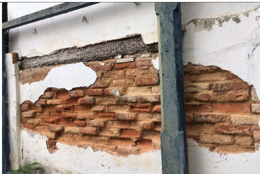
Figura 82. Alvenaria exposta de tijolinho de barro cozido na lateral oeste da casa sede - Fazenda Boa Esperança. Foto: Brenda Souza, 17/02/2022
