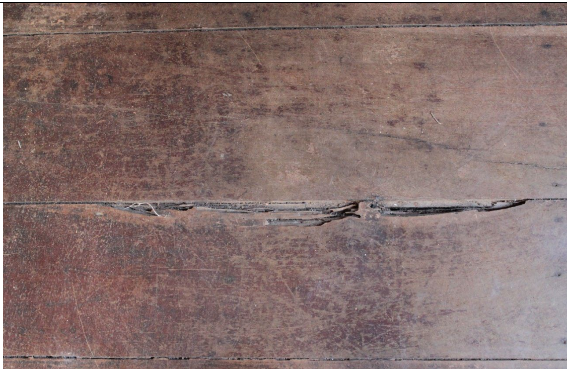
Figura 127. Piso de madeira tabuada da sala 10, com partes quebradas e vestígio de presença de espécies xilófagas. Foto: Isabella Alves, 19/01/2022.
