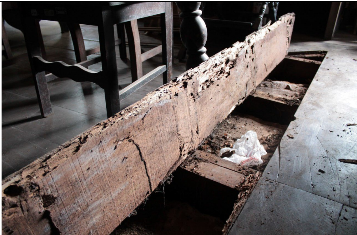
Figura 131. Abertura do piso de madeira tabuada da sala de banquetes (Sala 13), com muitos vestígios de espécie xilófaga. Piso de concreto sob os barrotes. Foto: Brenda Souza, 16/03/2022.
