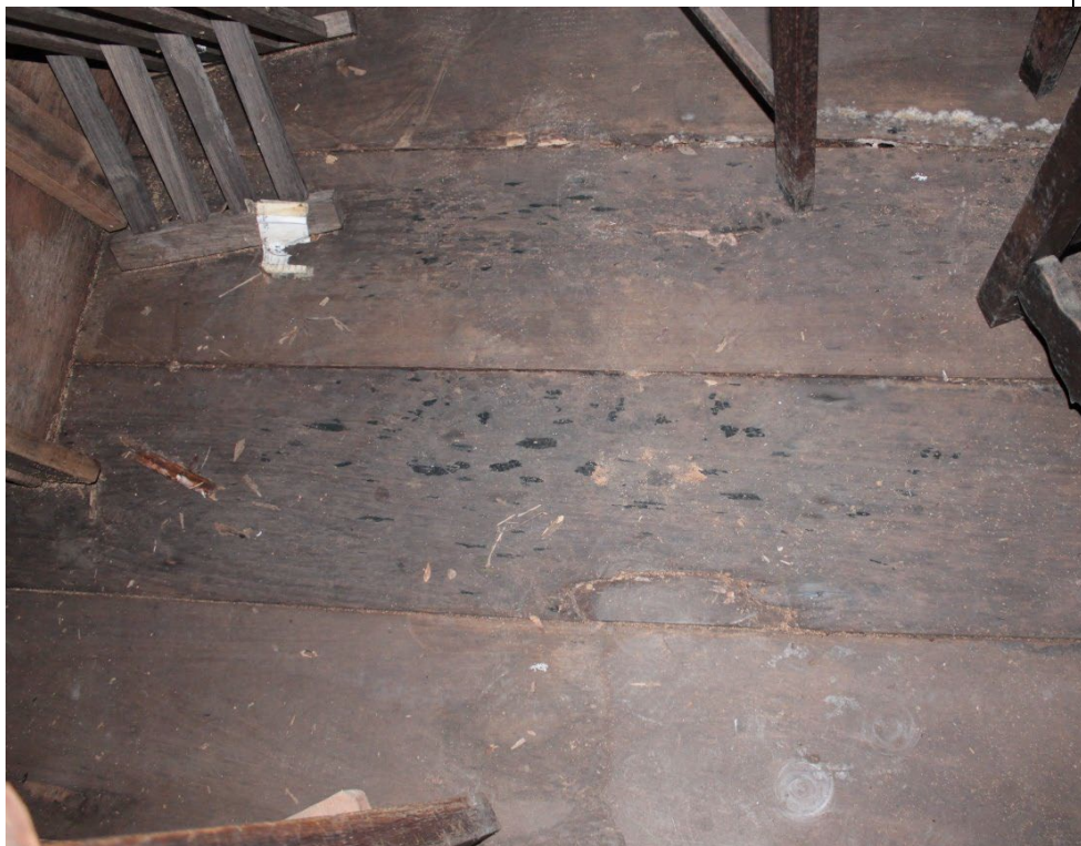
Figura 124. Piso de madeira tabuada da sala 8, bem comprometido devido infiltração de água do telhado e forro. Presença de manchas brancas (fungos). Foto: Isabella Alves, 19/01/2022.
