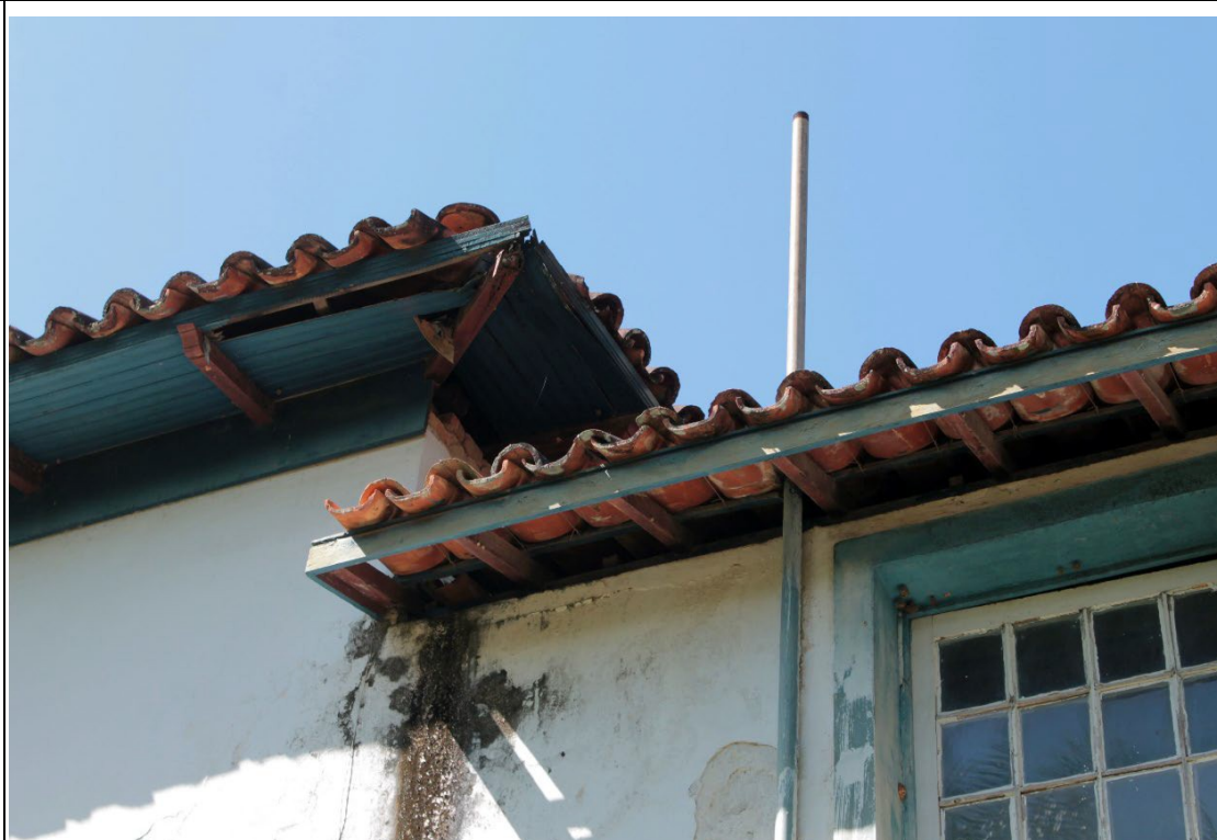
Figura 78. Vista de parte do beiral da fachada posterior da casa sede com perda de massa – Fazenda Boa Esperança. Visível falta de telhas da cobertura. Foto: Brenda Souza, 16/03/2022.
