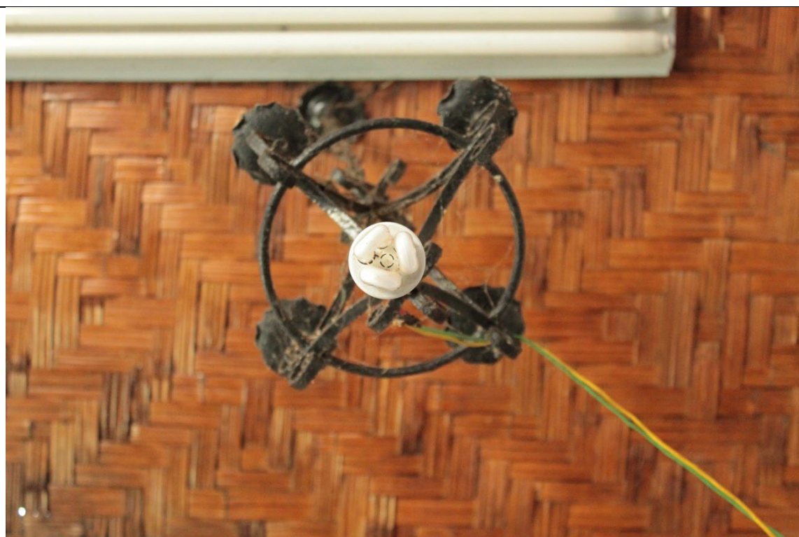
Figura 174. Luminária estilo colonial de ferro (original) com quatro boquilhas do tipo vela, ao lado, luminária com lâmpada tubular (não original), ambas localizadas na sala 7 (cozinha) – Fazenda Boa Esperança. Tipologia de luminária encontrada apenas nessa sala.
