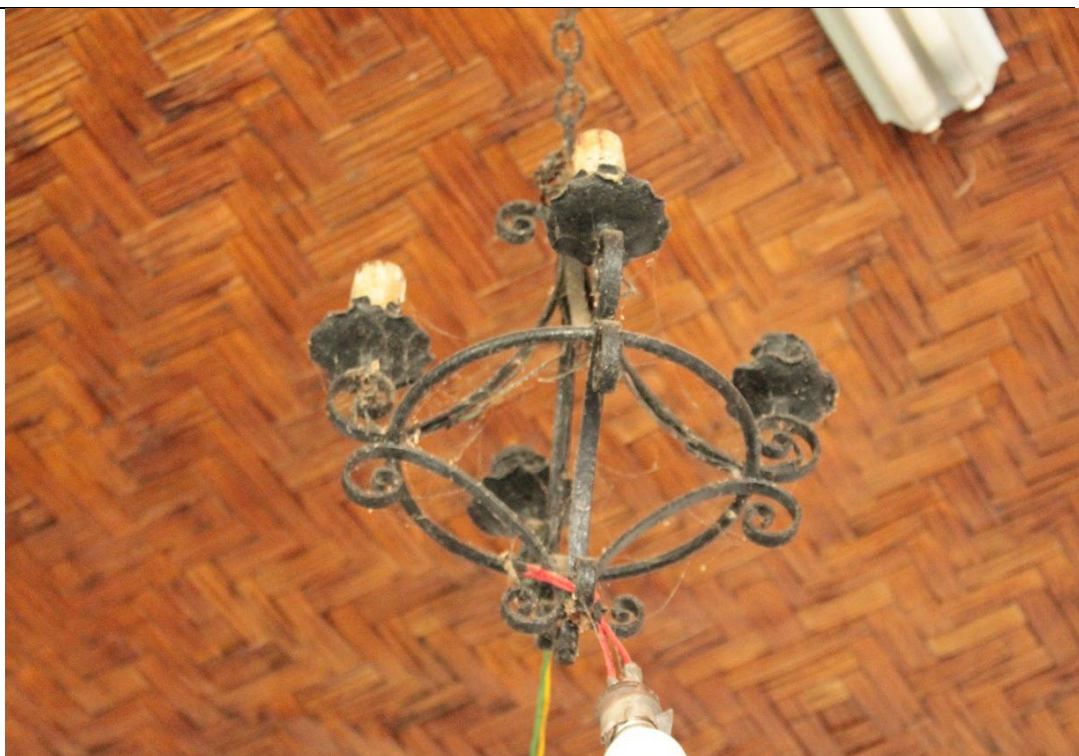
Figura 175. Luminária estilo colonial de ferro (original) com quatro boquilhas do tipo vela, localizada na sala 7 (cozinha) – Fazenda Boa Esperança. Tipologia de luminária encontrada apenas nessa sala. Foto: Brenda Souza, 16/03/2022..
