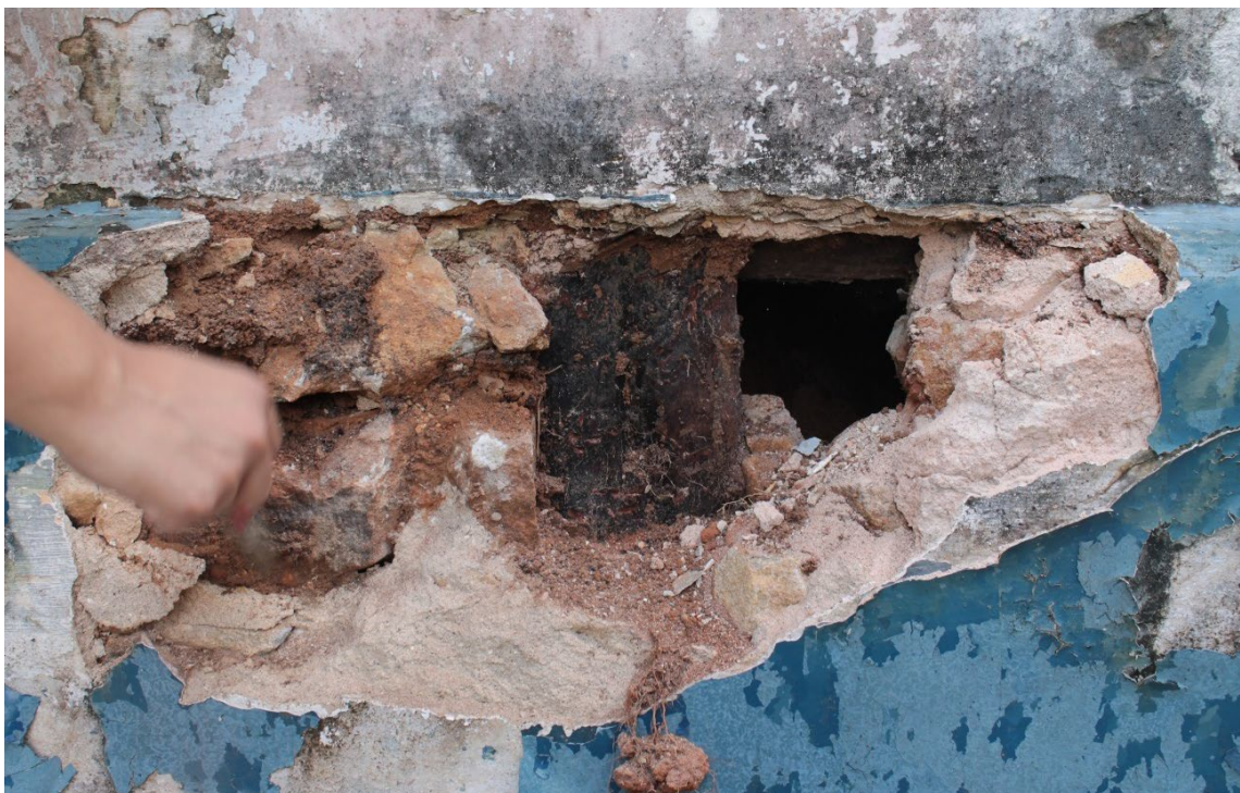
Figura 63. Prospeção feita do lado oeste da fachada frontal. Apresentação do esteio de madeira presente conectado a linha do baldrame. Esse, entre paredes de dois tipos construtivos: tijolinho de barro cozido e pedregulho. Em bom estado de conservação. Foto: Brenda Souza, 16/03/2022
