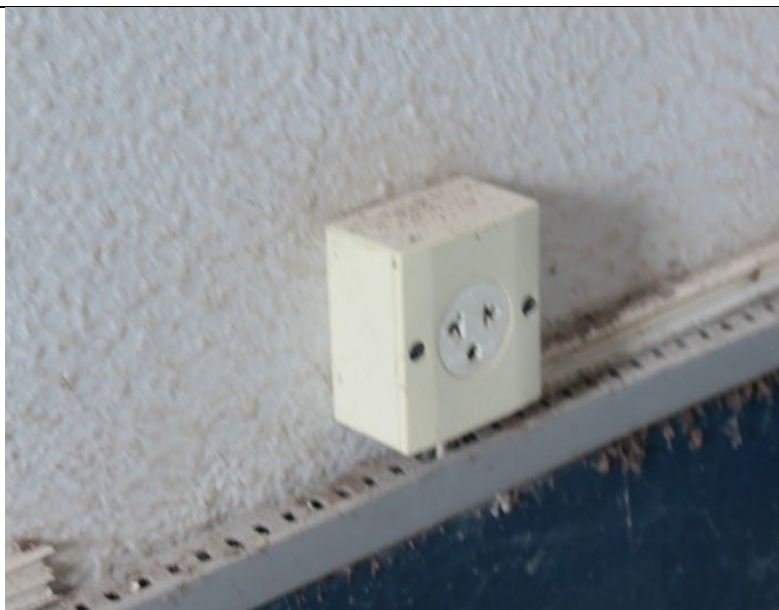
Figura 181. Tomada com fiação externa à parede, não original, localizada na sala 10 – Fazenda Boa Esperança. Foto: Brenda Souza, 17/02/2022.
