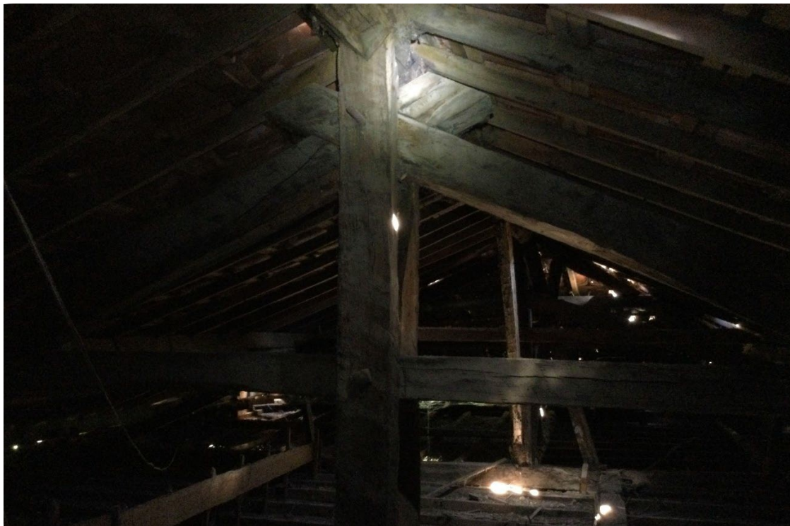
Figura 66. Vista de parte da estrutura da cobertura – Fazenda Boa Esperança. Estrutura de madeira (angelim ou canela). Visível deslocamento de telhas, demonstrado pela entrada de luz no local. Foto: Rogério Narciso, 16/03/2022.
