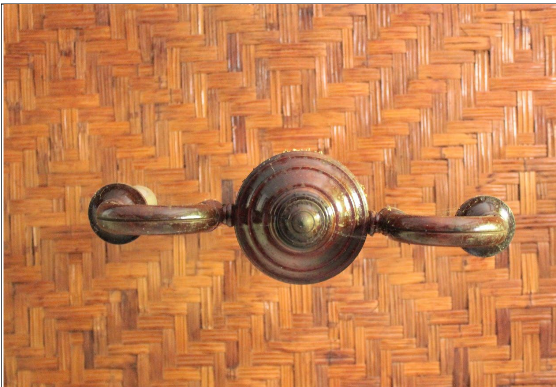
Figura 163. Luminária estilo colonial de madeira com duas boquilhas do tipo vela, localizada na sala 4, original da fazenda . Tipologia encontrada nas salas 4,9, 11 e 12. Foto: Brenda Souza, 16/03/2022.
