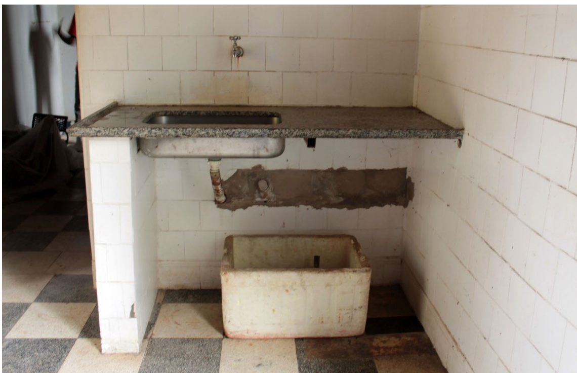
Figura 91. Presença de falta de peças (azulejos) abaixo da pia da cozinha após intervenção no encanamento – Fazenda Boa Esperança. Foto: Brenda Souza, 17/02/2022.
