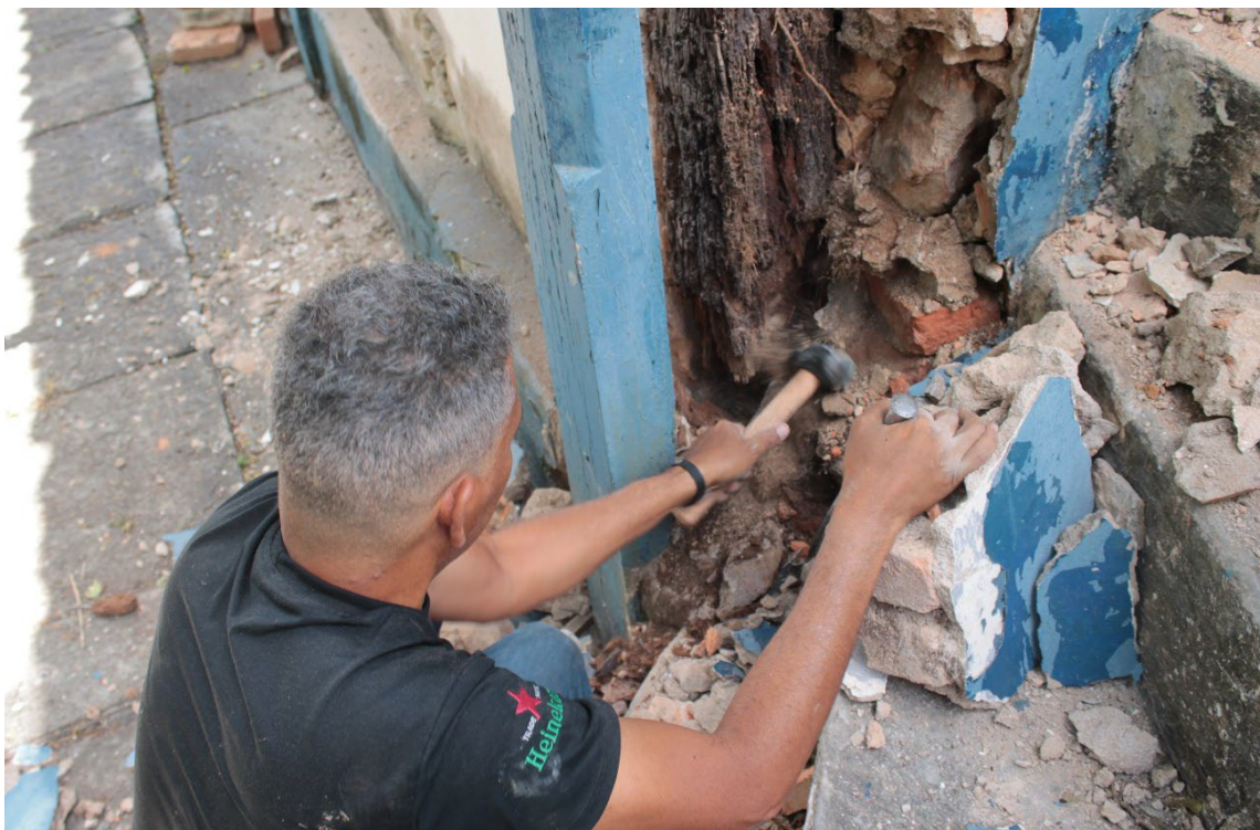
Figura 59. Restaurador fazendo prospecção no cunhal localizado na quina de encontro entre a lateral oeste e a fachada frontal da edificação – Fazenda Boa Esperança. Foto: Isabella Alves, 16/03/2022.
