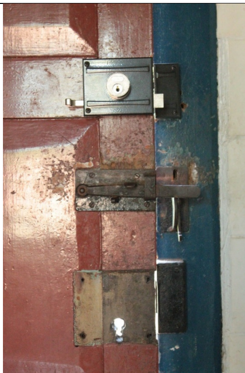
Figura 116. Diferentes fechaduras encontradas na porta de acesso da sala 7 (cozinha) para a área externa. Visto da sala 7. Foto: Brenda Souza, 23/02/2022.
