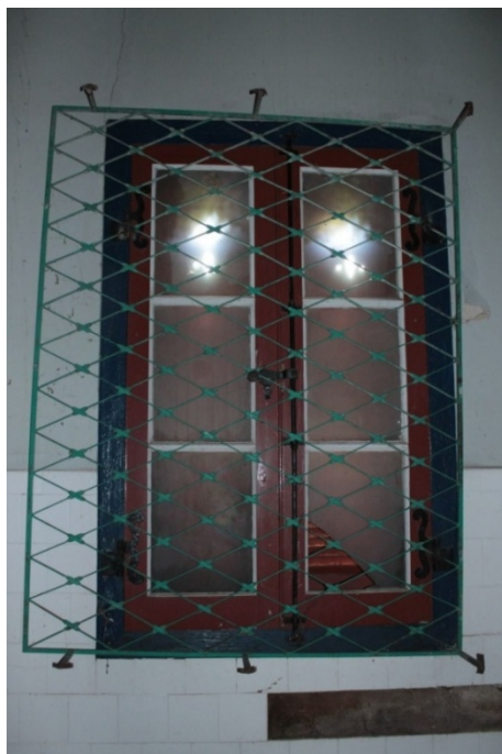
Figura 93. Janela da sala 3 (banheiro próximo à entrada principal), composta por 4 folhas de abrir, duas para fora (de madeira) e duas para dentro (de madeira e vidro), vista da dentro do cômodo.
