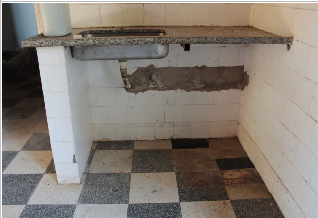
Figura 135. Piso de marmorite da sala 7 (cozinha), bem conservado, porém, com parte substituída por piso cerâmico, abaixo da bancada da pia. Foto: Isabella Alves, 19/01/2022
