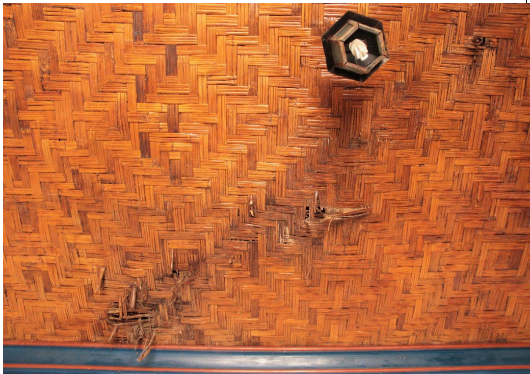
Figura 137. Forro de esteira de taquara da sala 1, apresentando manchas escuras, desgaste e abertura devido ao excesso de infiltração - Fazenda Boa Esperança. Foto: Isabella Alves, 19/01/2022.
