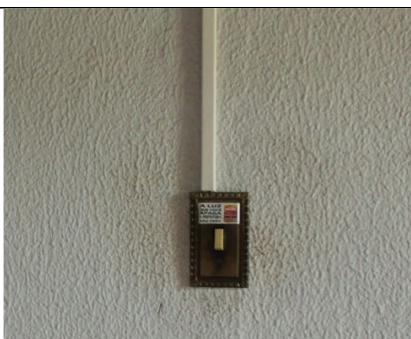
Figura 180. Interruptor original com intervenção não original, localizado na sala 9 – Fazenda Boa Esperança. Foto: Brenda Souza, 17/02/2022
