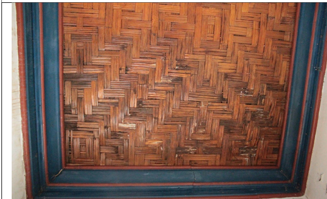
Figura 140. Forro de esteira de taquara da sala 5 (corredor para a cozinha) bastante danificado devido a infiltração. Com presença de manchas escuras e brancas (fungos) - Fazenda Boa Esperança. Foto: Isabella Alves, 19/01/2022.
