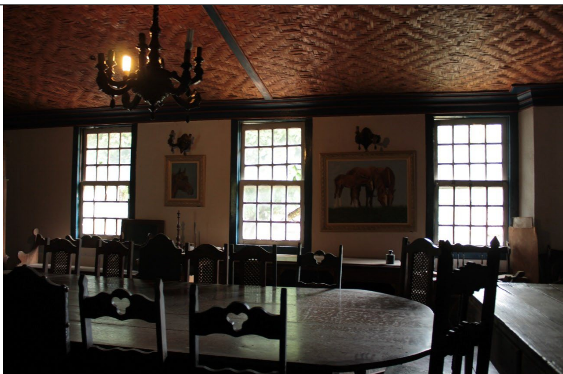
Figura 100. Janelas da sala 13, vistas de dentro, composta por 2 folhas do tipo guilhotina de madeira e vidro. Tipologia de janela encontrada nas salas 6, 7, 12 e 13. Foto: Brenda Souza, 17/02/2022.
