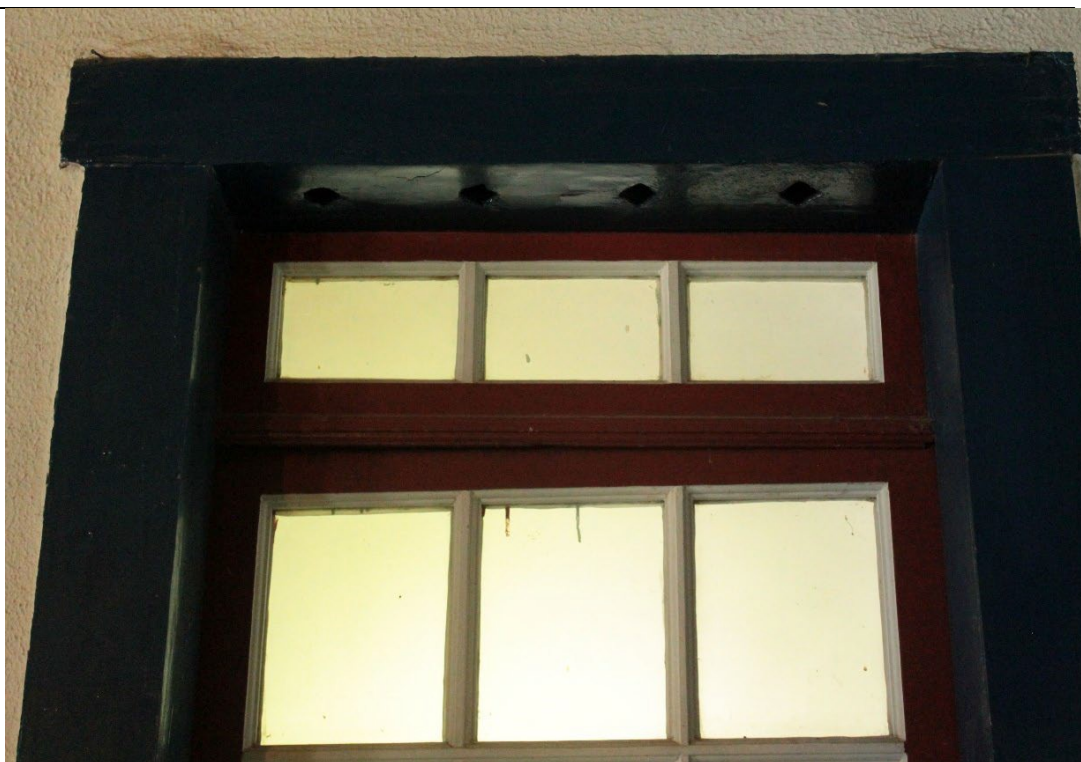
Figura 111. Detalhe encontrada apenas na porta de acesso à sala 4. Vista do interior da sala 13. Porta composta por 1 folha de madeira e vidro. Mesmo modelo de porta encontrada na sala 6 (banheiro), com exceção do tipo de vidro. Foto: Brenda Souza, 17/02/2022.
