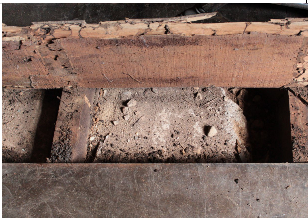
Figura 64. Baldrame sob o piso do salão de banquetes – Fazenda Boa Esperança. Base concretada. Foto: Brenda Souza, 16/03/2022
