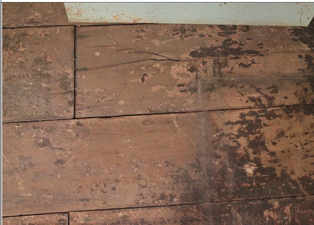
Figura 125. Piso de madeira tabuada da sala 10, com presença de várias manchas de água. Bastante comprometido devido infiltração. Presença de fungos. Foto: Isabella Alves, 19/01/2022
