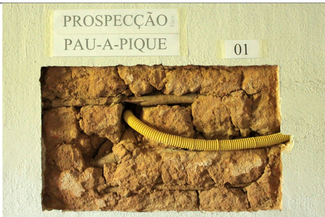
Figura 80. Prospecção nº 1 da sala 9 da casa sede – Fazenda Boa Esperança. Parede de vedação composta por pau-a-pique e revestida com argamassa de cimento e areia, encontrada em parte da varanda e das salas 2, 8, 9, 10 e 13. Foto: Brenda Souza, 17/02/2022.
