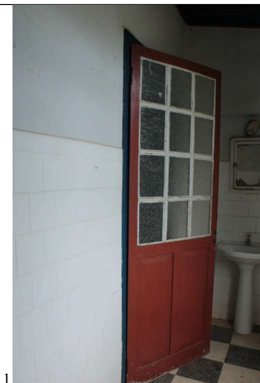
Figura 110. Porta de acesso à sala 6 (banheiro próximo à cozinha). Vista do interior da sala 6. Composta por 1 folha de madeira e vidro. Mesmo modelo de porta encontrada na sala 4, com exceção do tipo de vidro. Foto: Brenda Souza, 17/02/2022.
