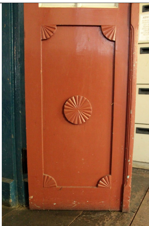
Figura 109. Detalhe de uma das folhas da porta de acesso da sala 9 para a sala 10, vista da sala 10. Composta por 2 folhas de madeira e vidro e detalhes ao redor feitos de material metálico pintado de preto (na parte de traz). Tipologia de porta encontrada nas sal
