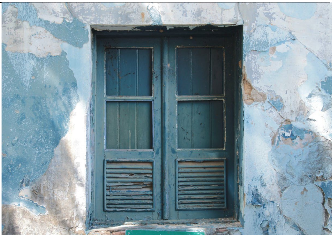
Figura 101. Janela do depósito/porão, vista de fora, composta por 2 folhas de madeira e vidro que abrem para fora e 2 folhas de madeira que abrem para dentro. Tipologia de janela encontrada apenas nesse cômodo. Foto: Brenda Souza, 16/03/2022.
