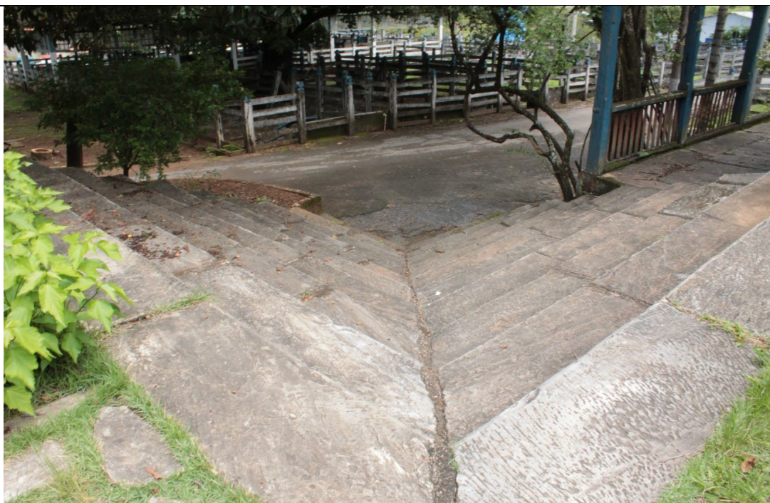
Figura 150. Escada revestida com pedra quartzito lajão que dá acesso ao lado oeste da edificação (curral e rua), localizada do lado oeste da fachada frontal da casa sede - Fazenda Boa Esperança. Vista de cima. Foto: Brenda Souza, 17/02/2022.
