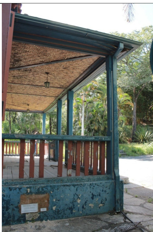
Figura 71. Vista do beiral e calha do alpendre frontal da casa sede – Fazenda Boa Esperança. Lateral esquerda (oeste) do alpendre. Foto: Brenda Souza, 16/03/2022.
