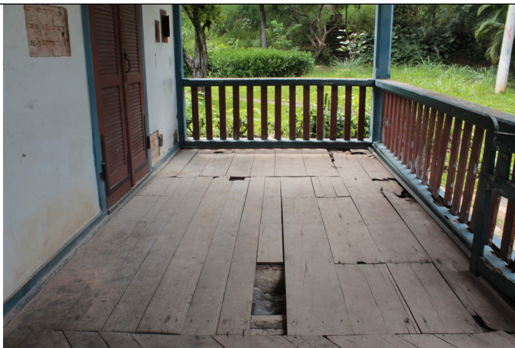
Figura 119. Piso de madeira tabuada da varanda em frente a edificação, bem degradado e com várias partes sem peças ou com peças quebradas. - Fazenda Boa Esperança. Foto: Isabella Alves, 19/01/2022.
