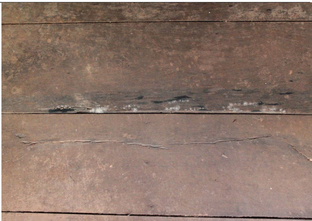
Figura 126. Piso de madeira tabuada da sala 10, com presença de manchas de água e manchas brancas correspondentes à fungos. Bastante comprometido devido infiltração. Presença de fungos. Foto: Isabella Alves, 19/01/2022.
