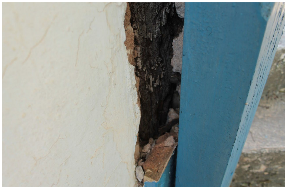
Figura 58. Cunhal exposto, localizado na quina de encontro entre a lateral oeste e a fachada frontal da edificação – Fazenda Boa Esperança. Foto: Isabella Alves, 19/01/2022
