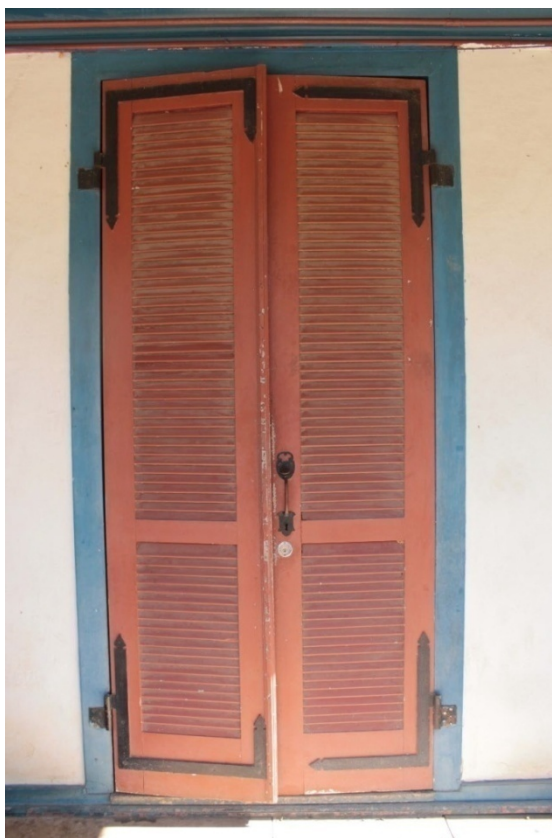
Figura 104. Porta da sala 1 vista por fora, composta por 4 folhas de abrir, duas para fora (de madeira) e duas para dentro (de madeira e vidro). Detalhes ao redor feitos de material metálico pintado de preto. Foto: Isabella Alves, 19/01/2022.
