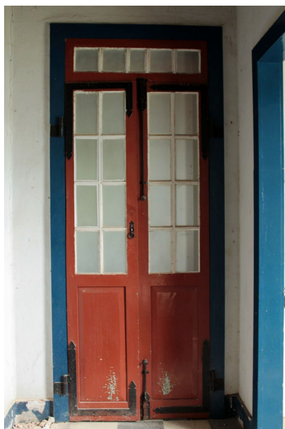
Figura 108. Porta de acesso da sala 5 (corredor próximo a cozinha) para a sala 13 (salão principal), vista da sala 5. Composta por 2 folhas de madeira e vidro e detalhes ao redor feitos de material metálico pintado de preto. Tipologia de porta encontrada nas salas:
