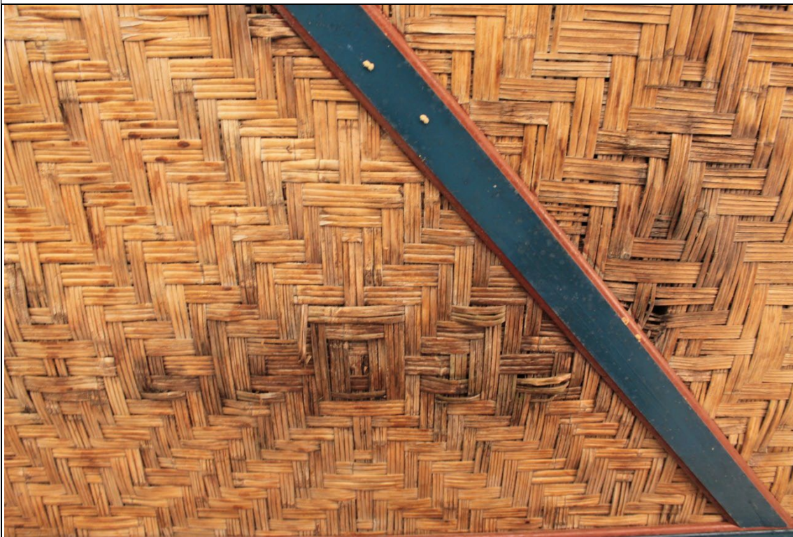
Figura 136. Forro de esteira de taquara da varanda em frente à edificação com presença de manchas escuras devido a infiltração - Fazenda Boa Esperança. Foto: Isabella Alves, 19/01/2022.
