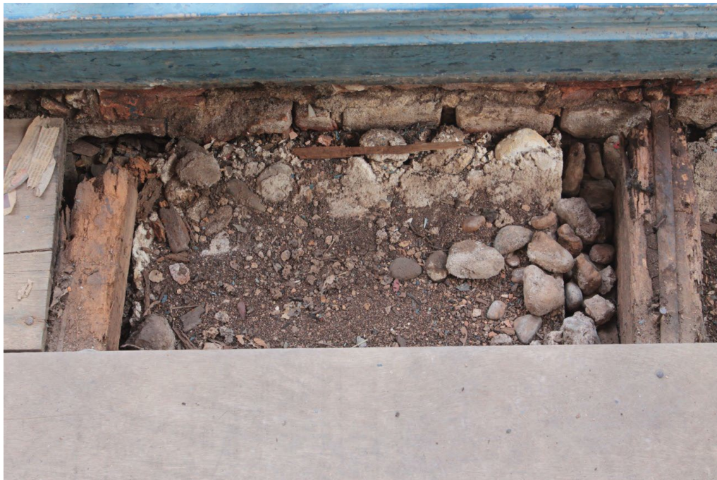
Figura 65. Baldrame sob o piso da varanda/alpendre frontal – Fazenda Boa Esperança. Bem comprometido, apresentando perda de massa e vestígios de espécies xilófaga. Base concretada. Foto: Isabella Alves, 16/03/2022
