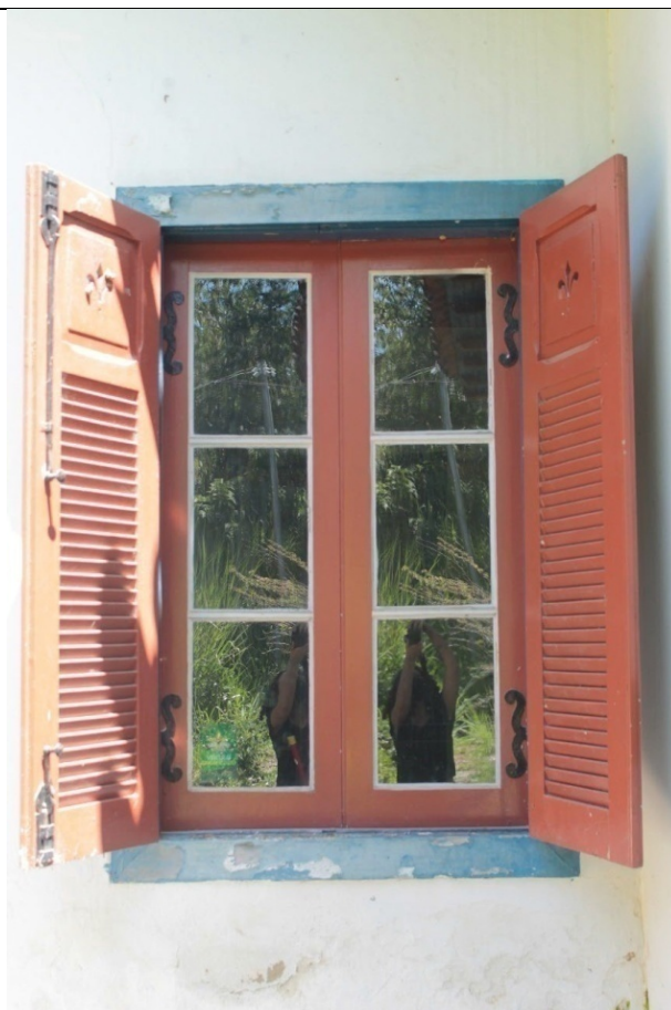
Figura 94. Janela da sala 4, vista de fora, com vestígios de presença de partes de tinta descascadas. Composta por 4 folhas
