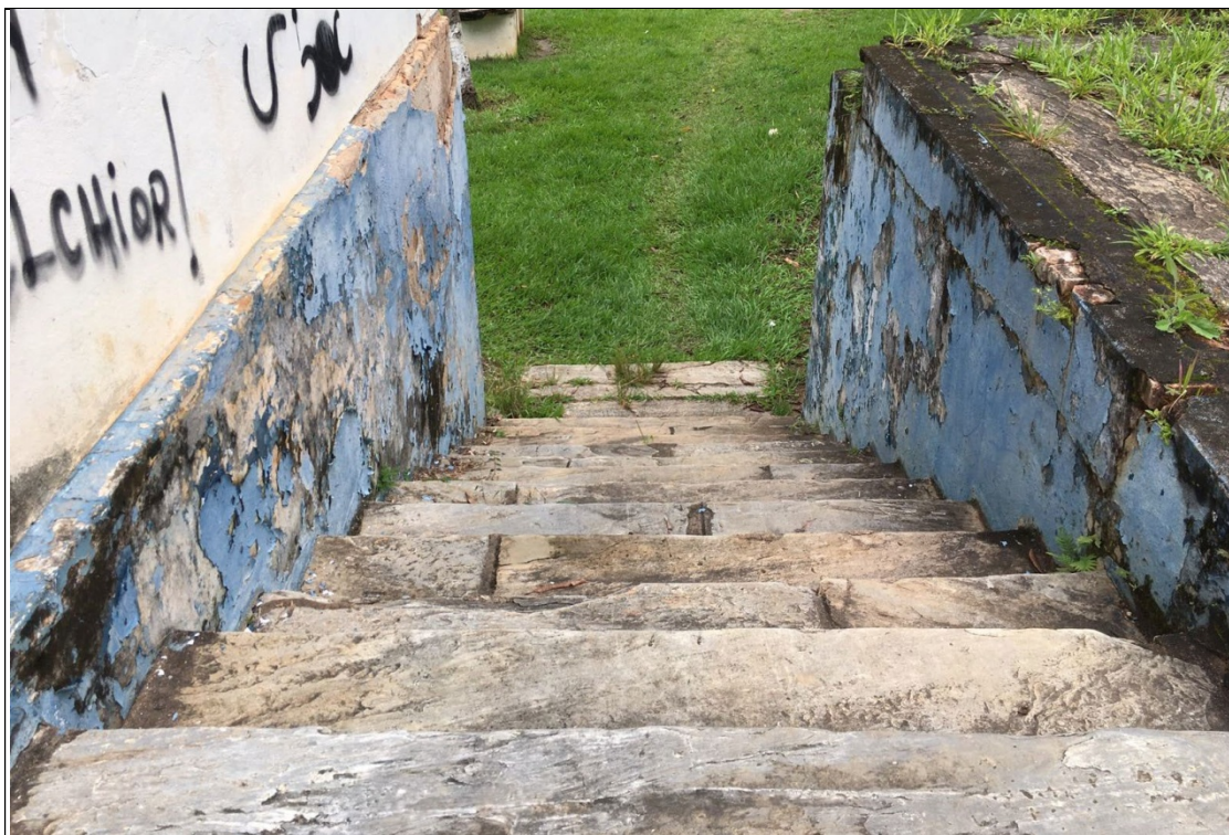
Figura 155. Escada revestida com pedra quartzito lajão que dá acesso ao fundo da edificação (pátio à norte), localizada do lado leste da casa sede - Fazenda Boa Esperança. Foto: Brenda Souza, 17/02/2022.
