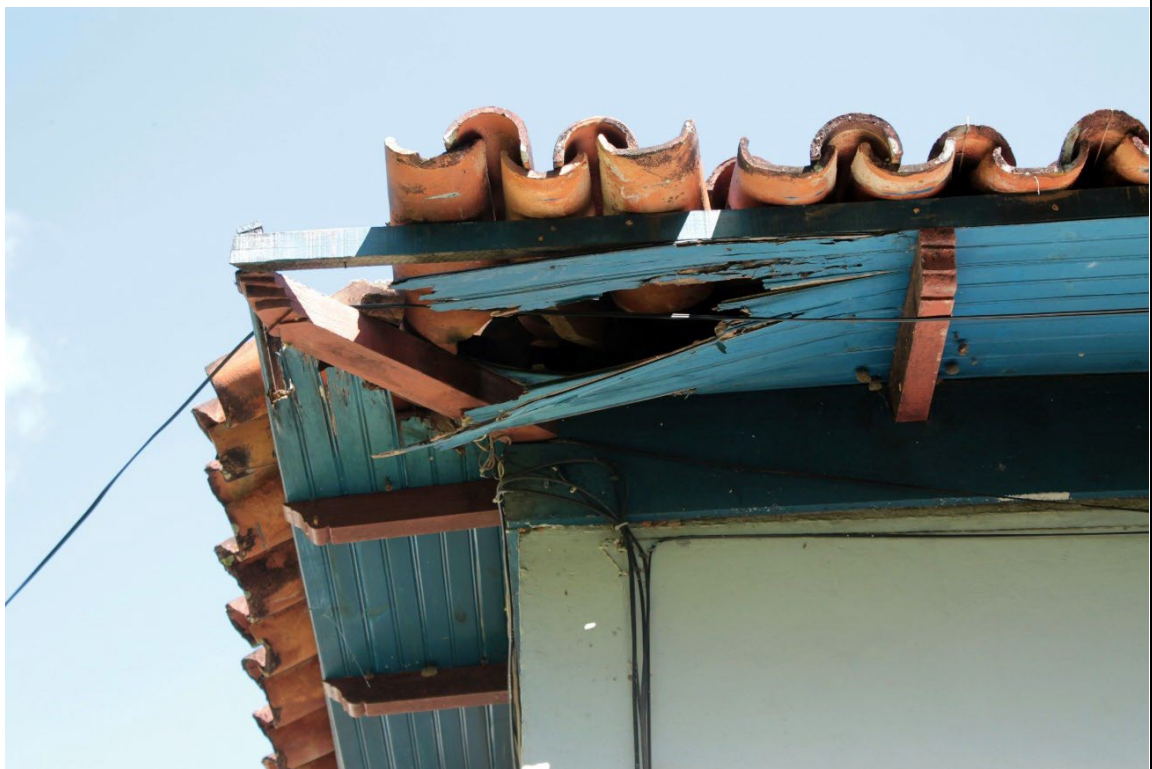
Figura 76. Vista de parte do beiral da lateral leste da casa sede com perda de massa – Fazenda Boa Esperança. Parte do telhado da cozinha com falta de telha. Foto: Brenda Souza, 16/03/2022.
