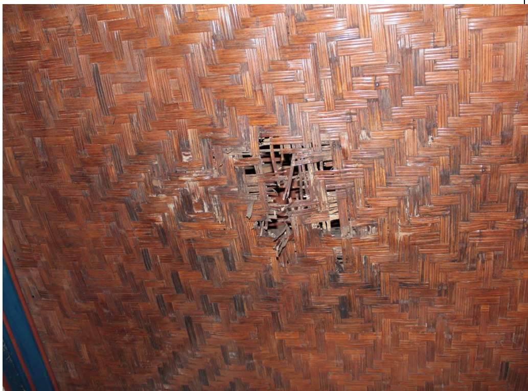
Figura 143. Forro de esteira de taquara da sala 8 muito comprometido, com aberturas e presença de manchas escuras devido a infiltração - Fazenda Boa Esperança. Foto: Isabella Alves, 19/01/2022.
