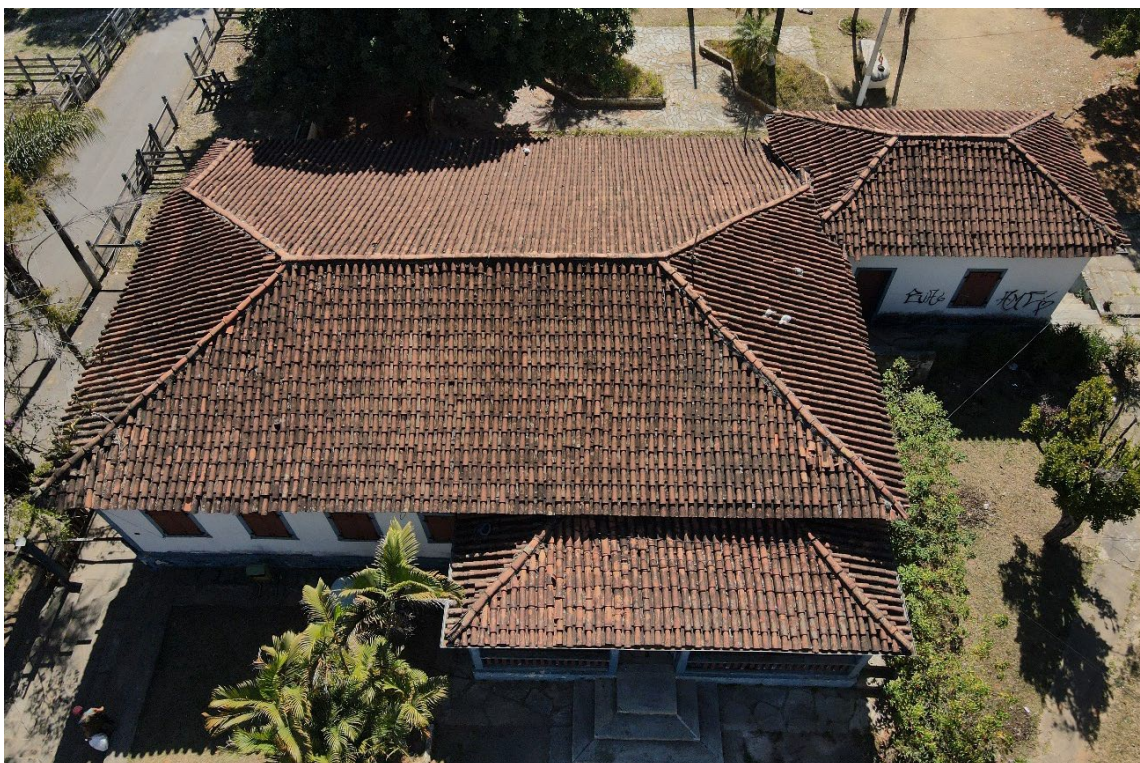
Figura 68. Vista área da cobertura da casa sede – Fazenda Boa Esperança. Cobertura composta por telha cerâmica colonial curva. Fachada frontal localizada na parte inferior da imagem. Foto: Alexandre Nery, 19/07/2021
