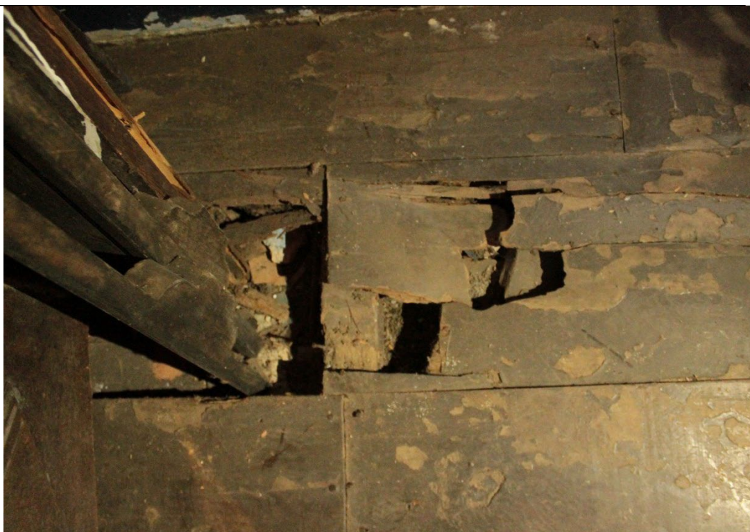
Figura 130. Piso de madeira tabuada da sala de banquetes (sala 13), com presença de remates, sobretudo próximos ao corredor perto da cozinha. Foto: Brenda Souza, 17/02/2022.
