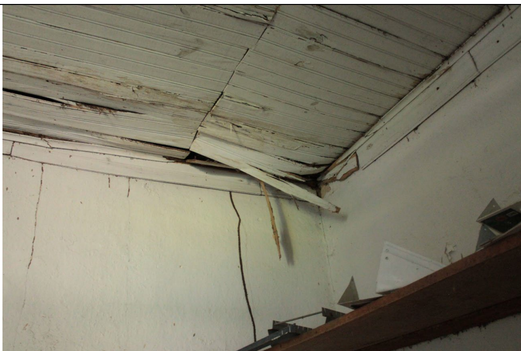
Figura 147. Forro de esteira da sala 11, extremamente desnivelado e comprometido devido a umidade - Fazenda Boa Esperança. Foto: Isabella Alves, 19/01/2022.
