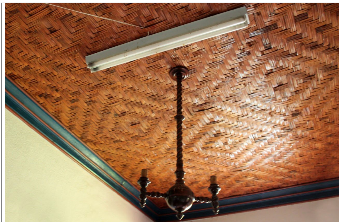
Figura 166. Luminária estilo colonial de madeira com duas boquilhas do tipo vela (original), ao lado, luminária com lâmpada tubular (não original) localizadas na sala 9. Tipologia encontrada nas salas 4,9, 11 e 12. Foto: Brenda Souza, 17/02/2022
